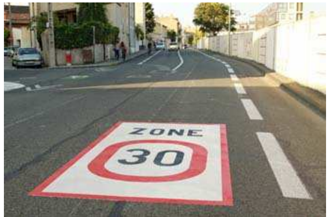
Entrée de la zone 30, rue Denis Papin
