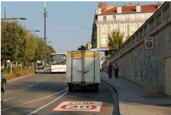
Entrée de la zone 30, avenue Gambetta
